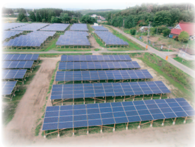
6,384枚のパネルを設置したメガソーラー発電所
